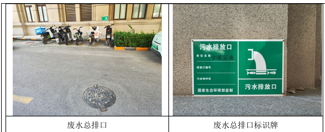
图 3-1 本项目环保设施与排污口规范化设置情况照片
