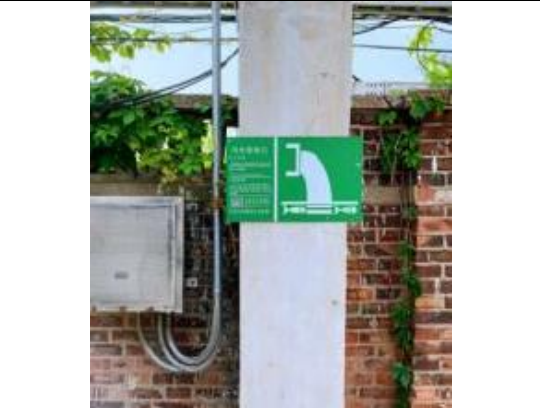
炼油部废水排放口
