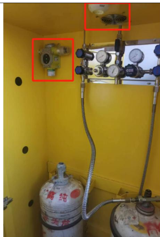
乙炔气瓶间探测器、报警器、应急风机
