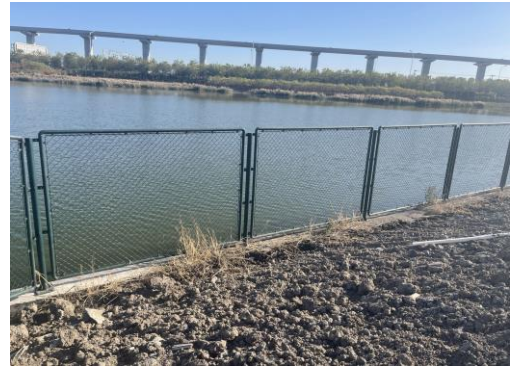
泵站南侧——施工结束后
