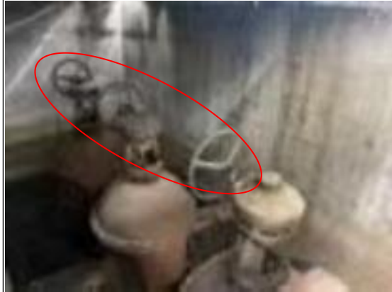
雨水排口截止阀（顺时针为关闭）
