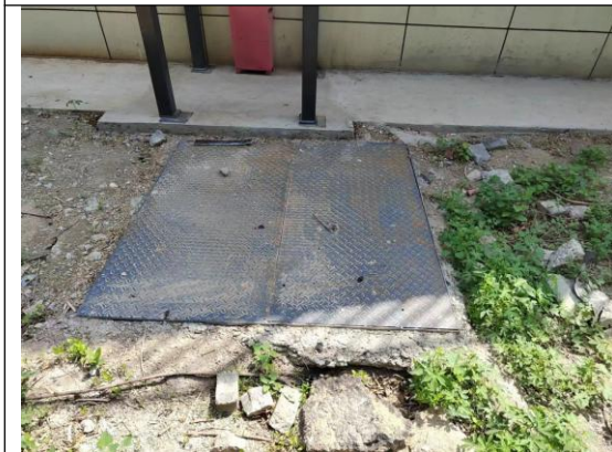
危险化学品库废液收集池
