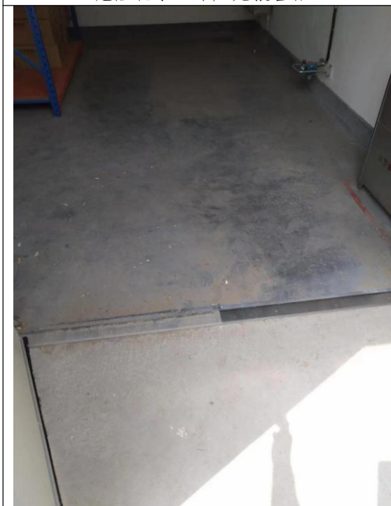
危险化学品库出入口缓坡
