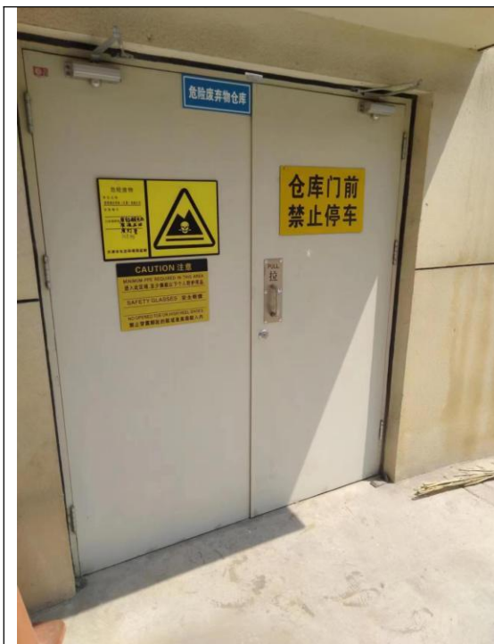
危险废物暂存间
