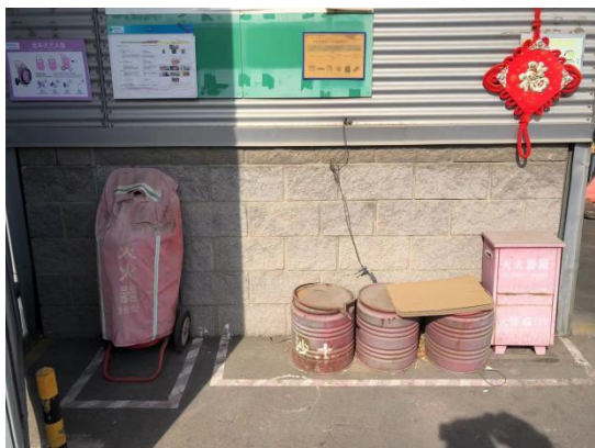
危废暂存间外灭火器、沙土、灭火器、消防沙袋等应急物资
