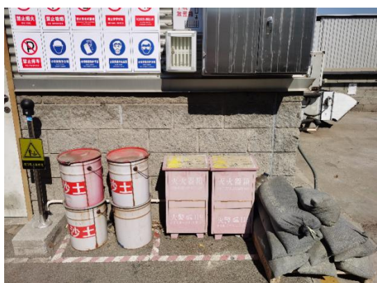
化学品暂存室外沙土、灭火器、消防沙袋等 应急物资
