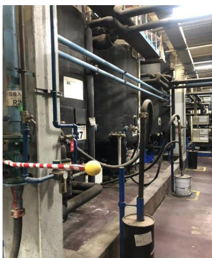
7 个 VPI 储罐区及围堰
