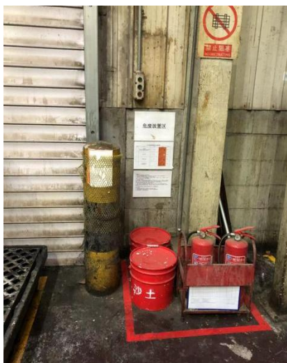
灭火器、消防沙土
