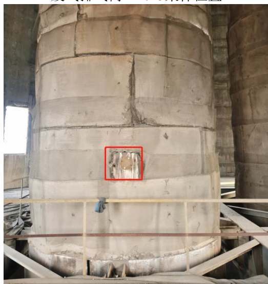
废气排气筒DA002采样位置
