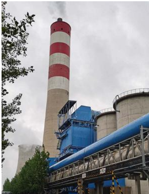
150m高焚烧废气排气筒DA002外部
