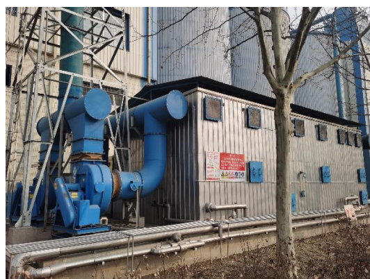
依托原有生物除臭净化系统
