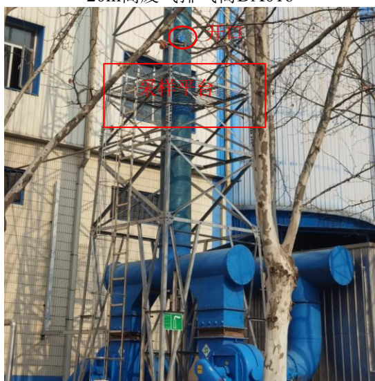
废气排气筒DA013采样位置
