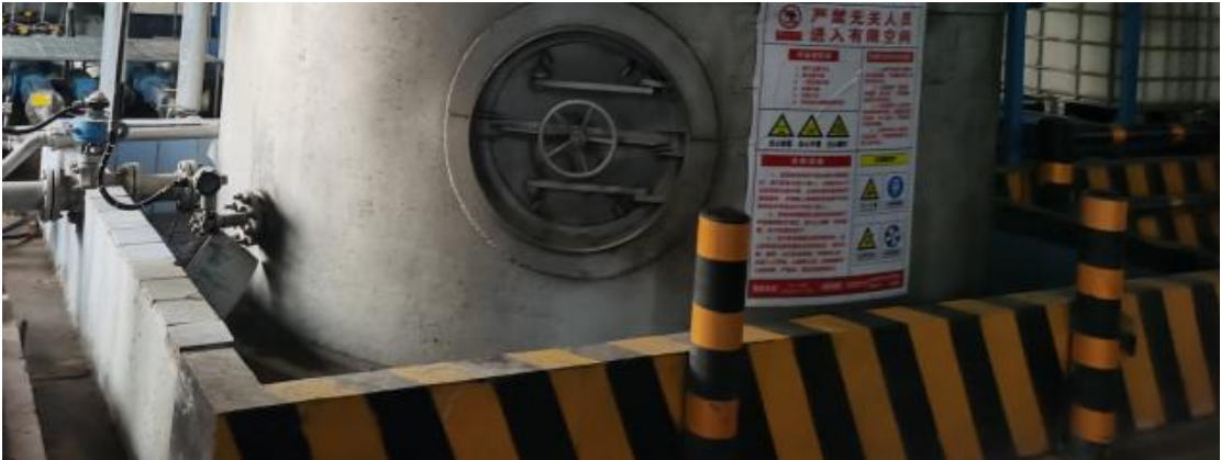
碱液储罐围堰
