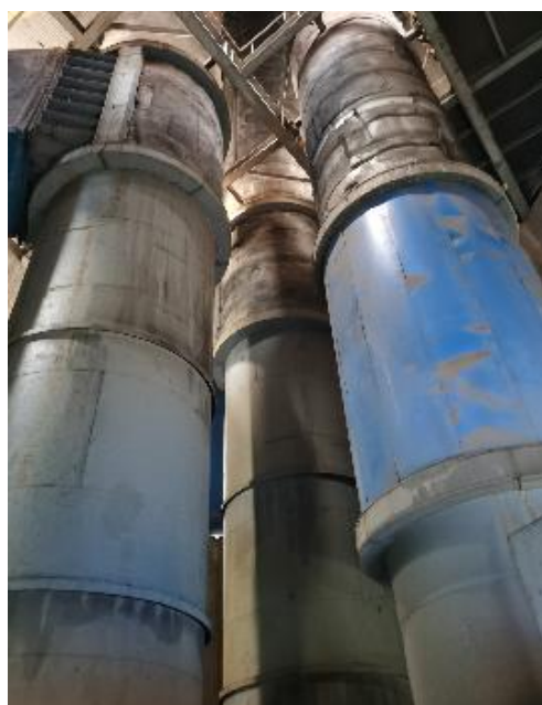
废气排气筒DA002内部套筒（左中右依次为500t/h锅炉、400t/h锅炉、焚烧炉的排气筒）
