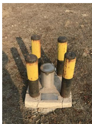
地下水井照片 (S3)
