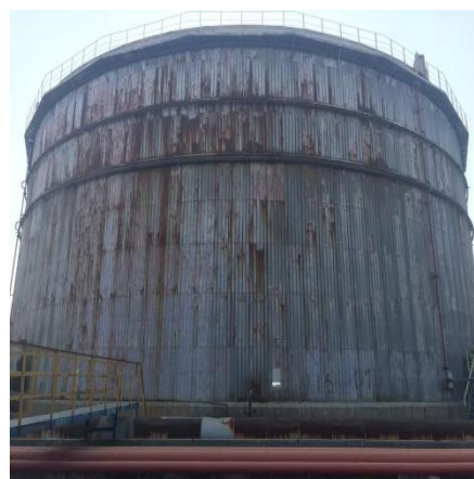
产品罐区围堰
