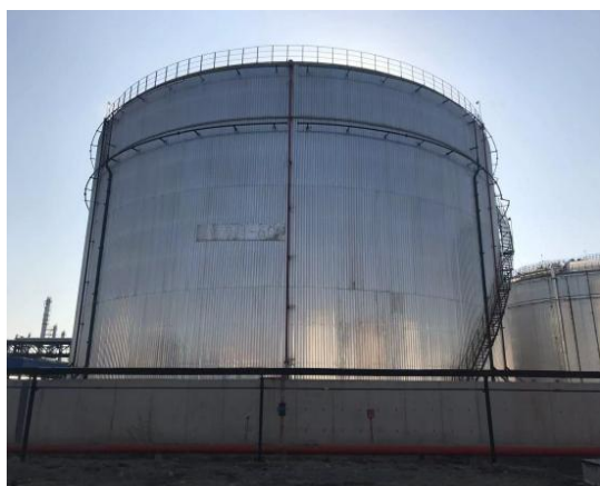
催化渣油罐区围堰
