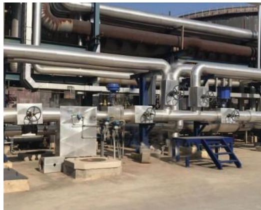
调和管道系统管廊集中阀门区抗渗混凝土地面
