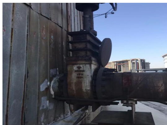
产品储罐阀门法兰密封照片
