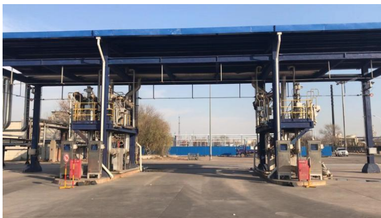
船用油装车栈台界区内抗渗混凝土地面
