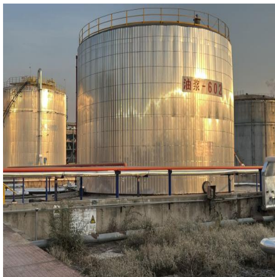
催化油浆储罐围堰
