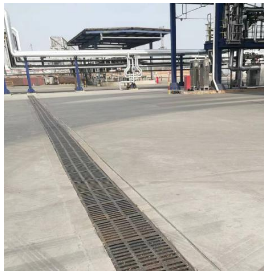
装卸栈台集水沟
