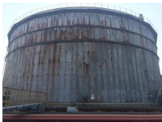
利旧产品储罐 (外浮顶罐)
