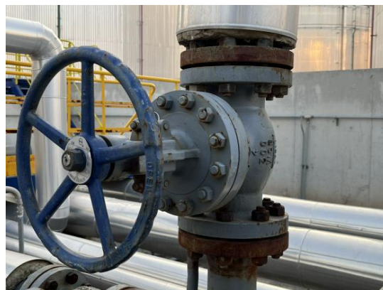
加氢渣油储罐法兰密封照片
