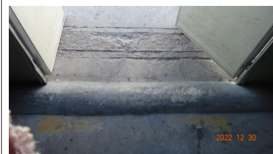
废电池存储区出口缓坡
