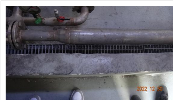
NMP 仓库泄漏槽及围堰
