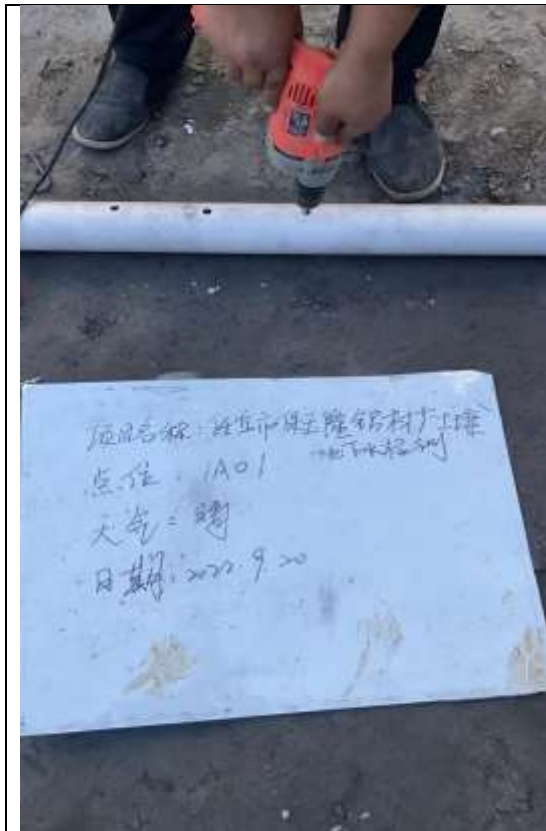
滤水管钻孔
