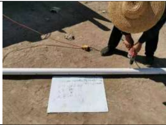
滤水管钻孔
