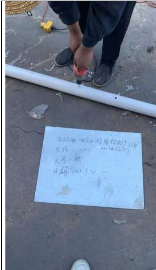
滤水管钻孔
