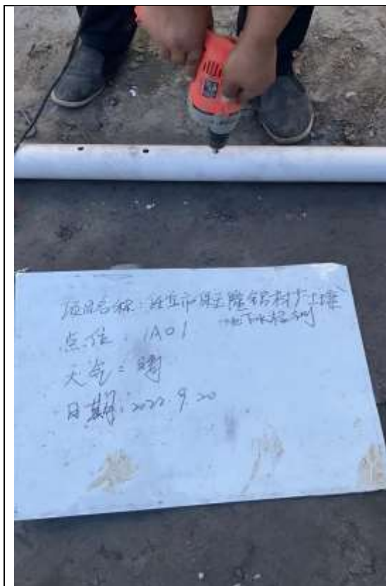
滤水管钻孔
