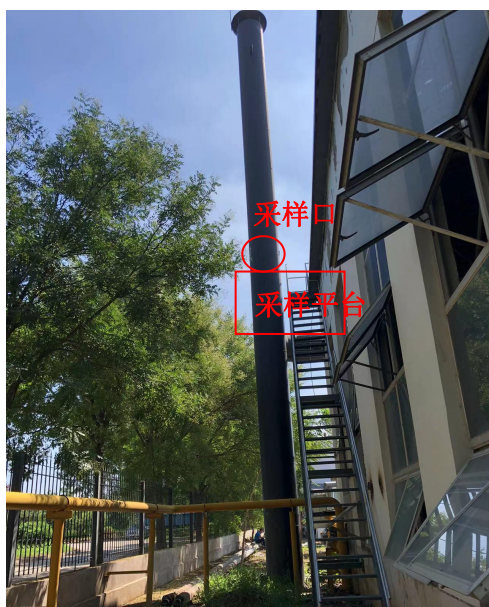
排气筒 DA004（采样口、采样平台）
