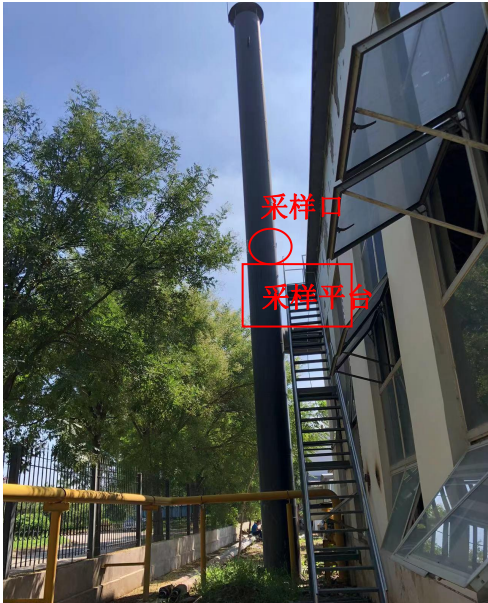
排气筒 DA004（采样口、采样平台）
