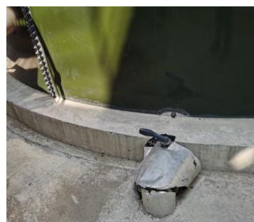
污水管道手动截止阀
