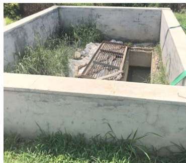
雨水收集暂存池
