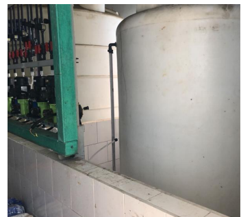
储罐围堰
