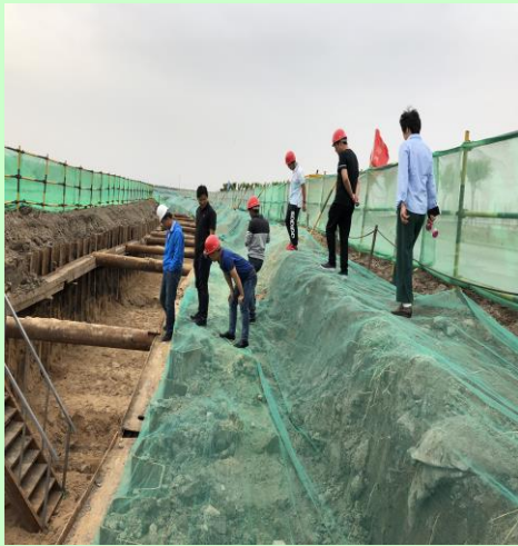
对施工物料和裸露地面进行苫盖
