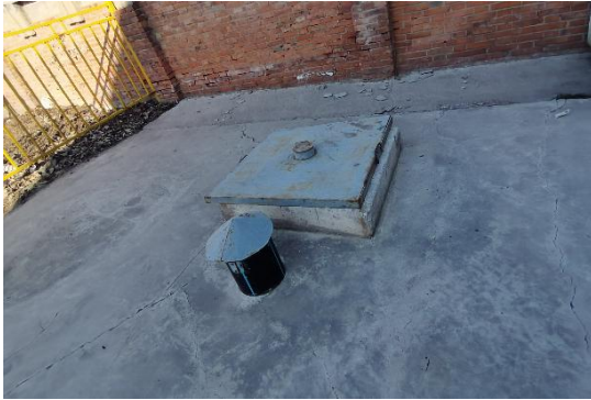
危废暂存间地下收集池
