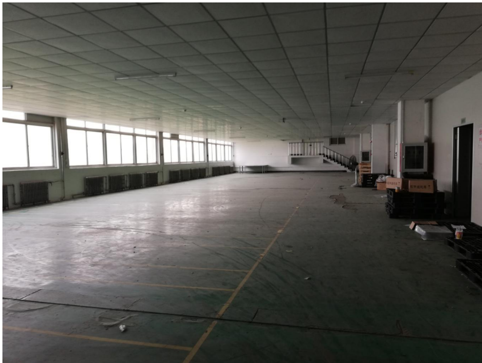
图 1-4 厂房现状照片
