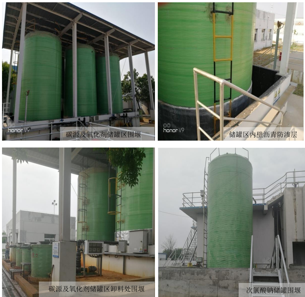
图 3-4 风险防止泄漏围堰及内部防渗照片
