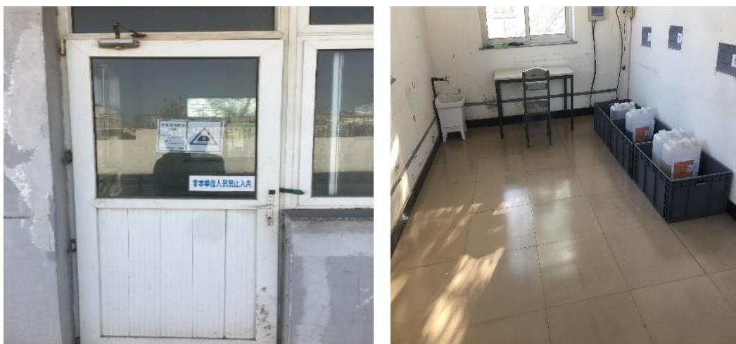
图 3-3 危废暂存间外部及内部照片
