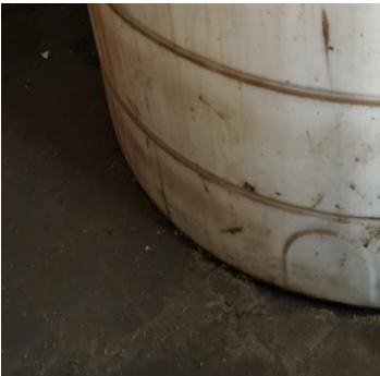
罐内地面防腐防渗
