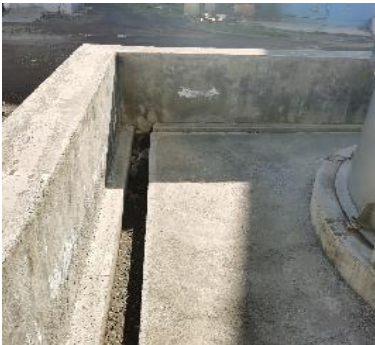
氨水罐区围堰及收集沟槽
