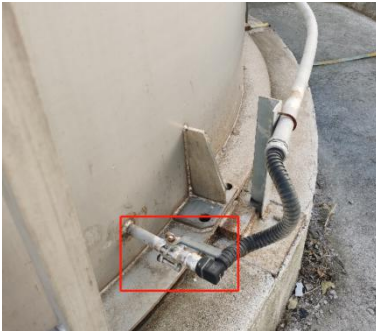
氨水罐手动阀
