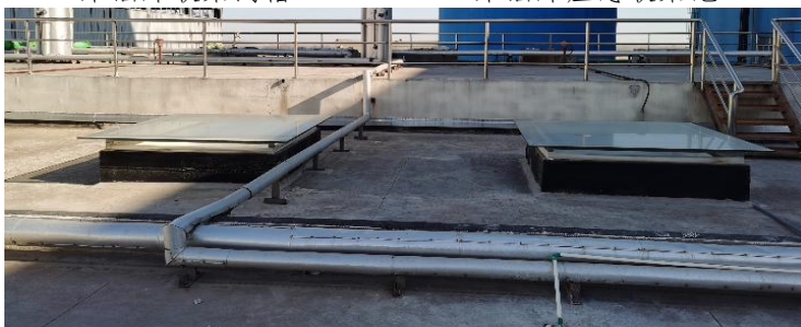
事故池与渗滤液调节池顶部
