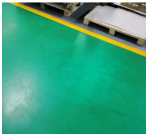
车间内地面防腐防渗
