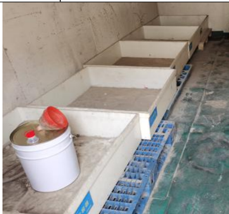
化学品库防渗漏托盘
