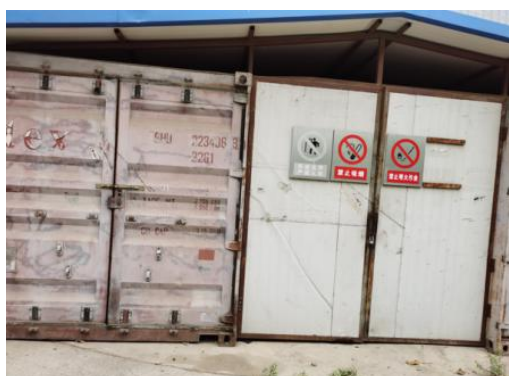
化学品库外部
