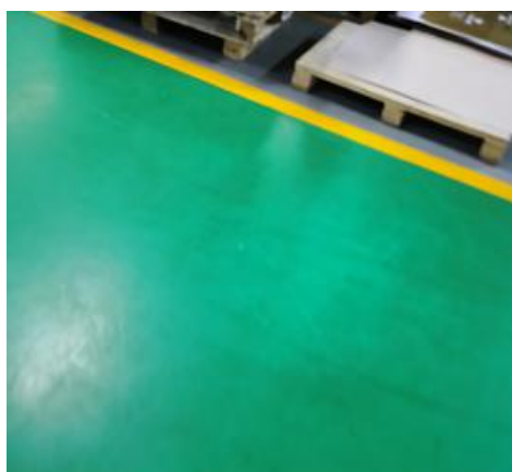
车间内地面防腐防渗
