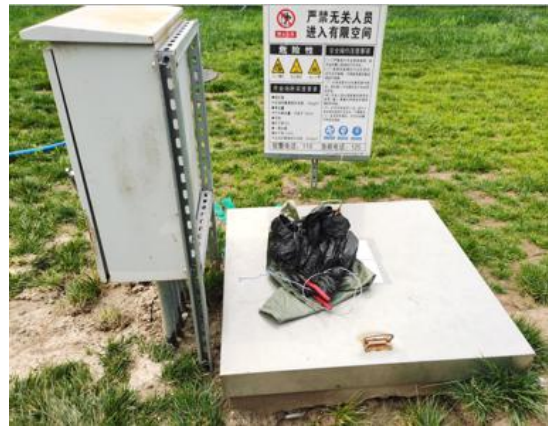
厂区南侧雨水收集池
