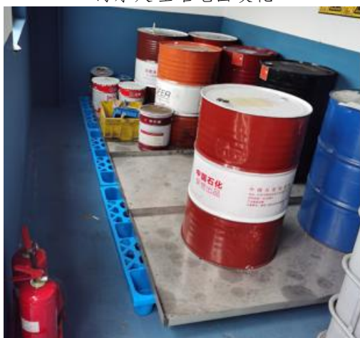
危废暂存间地面硬化
