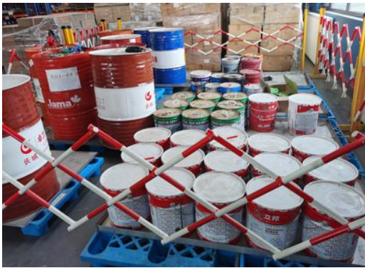
原料存放间包装桶底部防渗漏托盘
