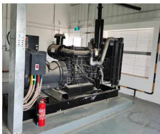
柴油发电机房地面硬化
