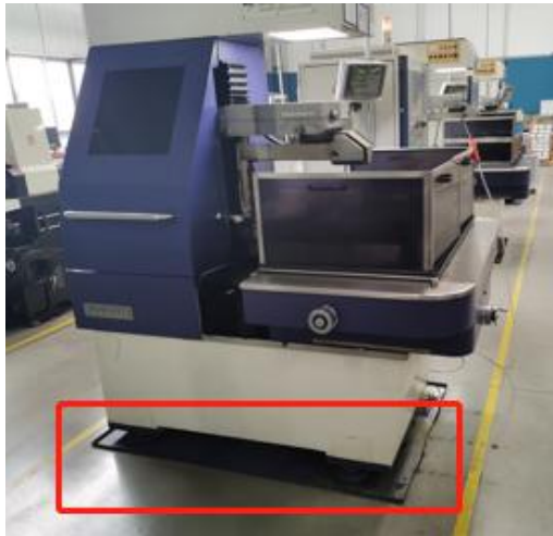
切削设备底部防渗漏托盘
