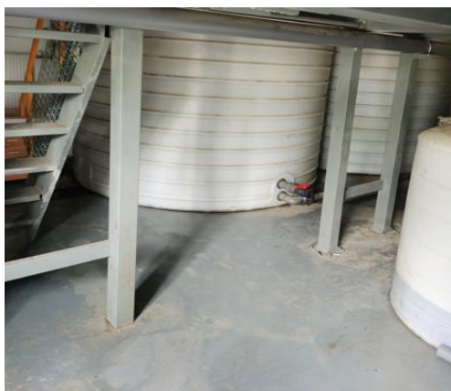
污水处理站地面硬化
