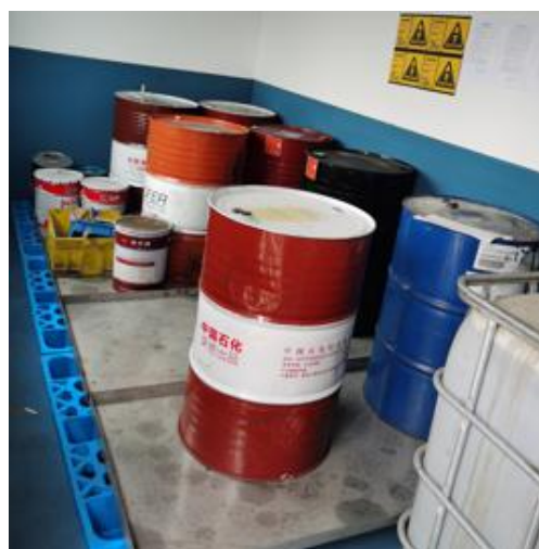
原料存放间容器底部防渗漏托盘
