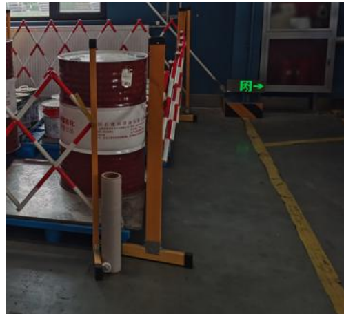
原料暂存间地面硬化
