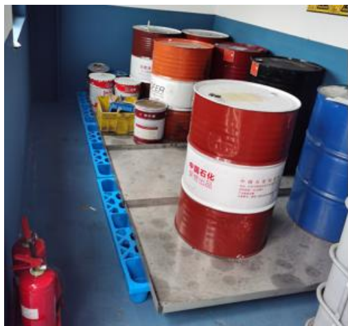
危废暂存间地面硬化
