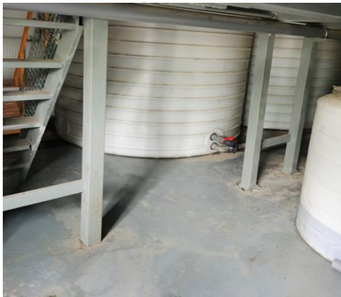
污水处理站地面硬化
