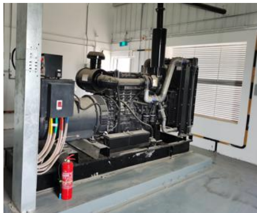
柴油发电机房地面硬化
