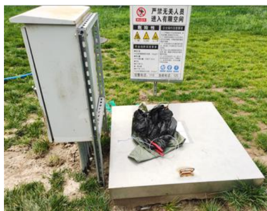
厂区南侧雨水收集池
