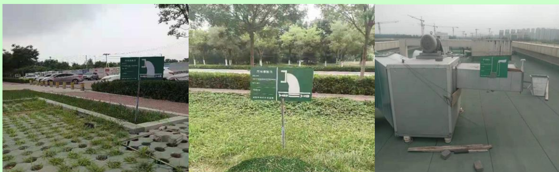
图 4-10 废水排放口、废气总排口标志牌
