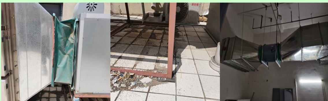
图 4-8 柔性连接和减震垫
