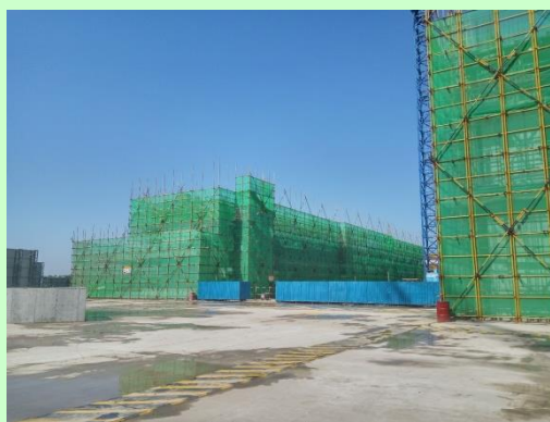
施工场地进出口地面硬化、设置围挡 及洒水降尘
