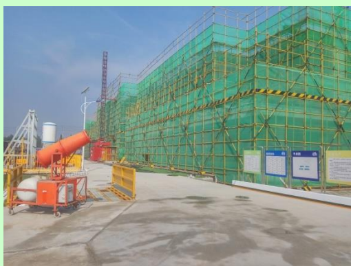
现场配备喷雾降尘机进行不定时 降尘处理
