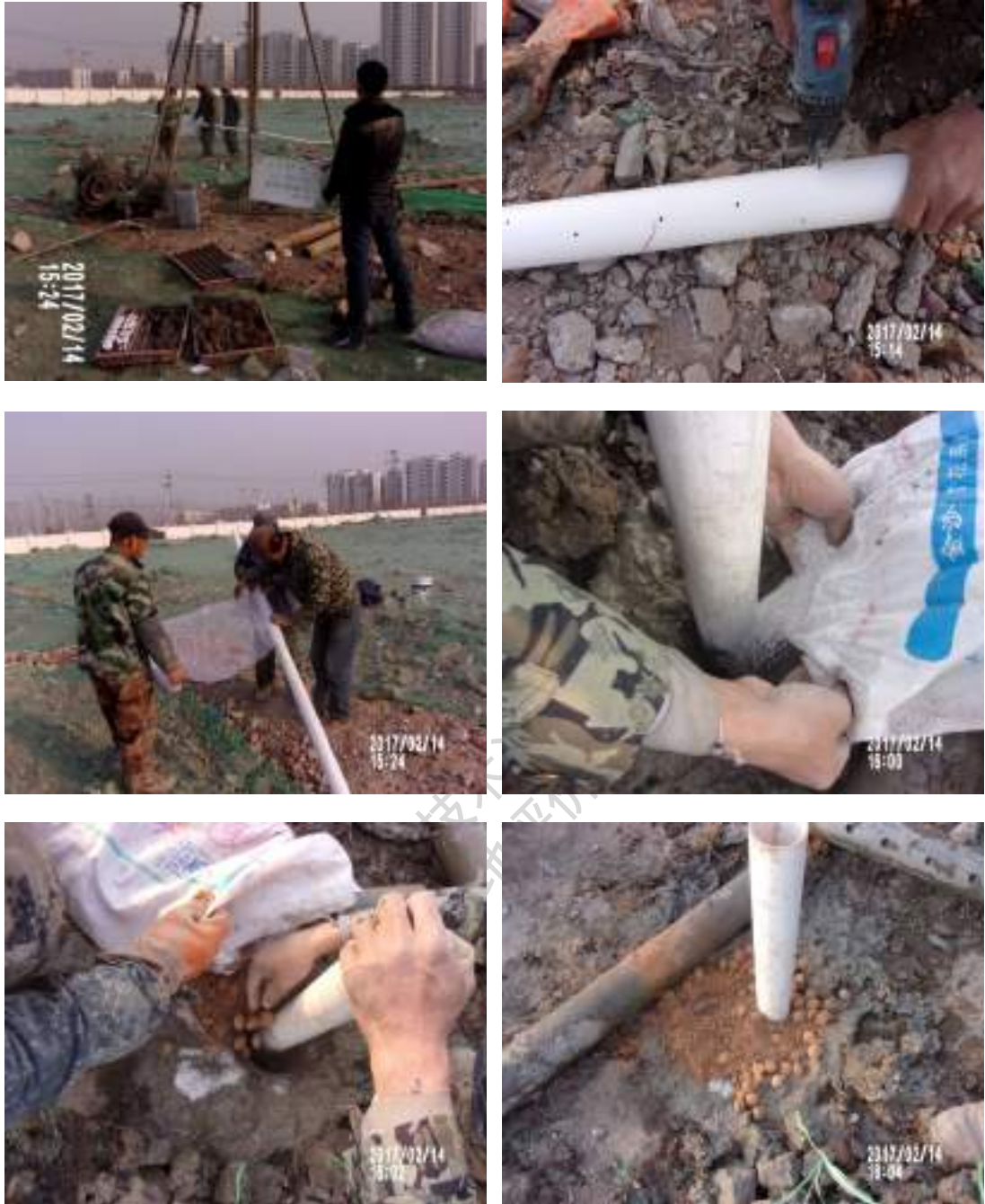
图 5.1-5 钻机钻探、下管及建井过程
