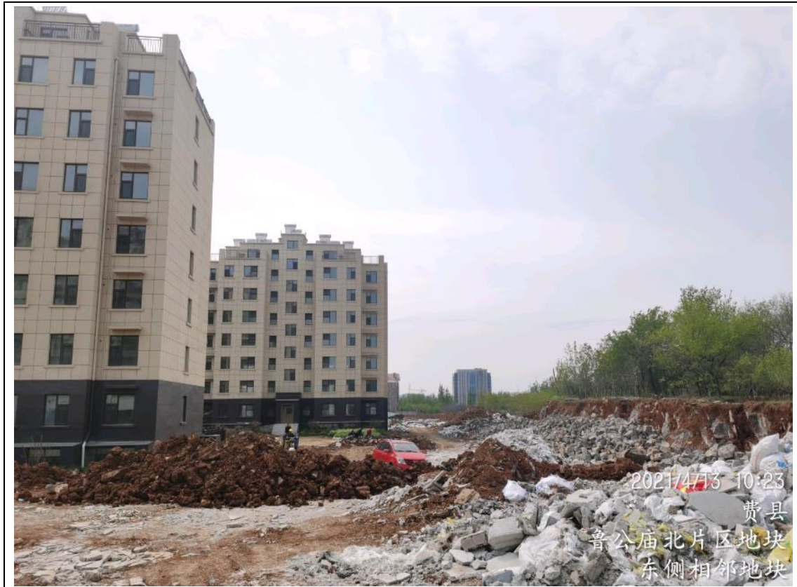
东侧相邻地块（在建小区）
