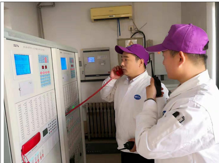
现场演练照片
