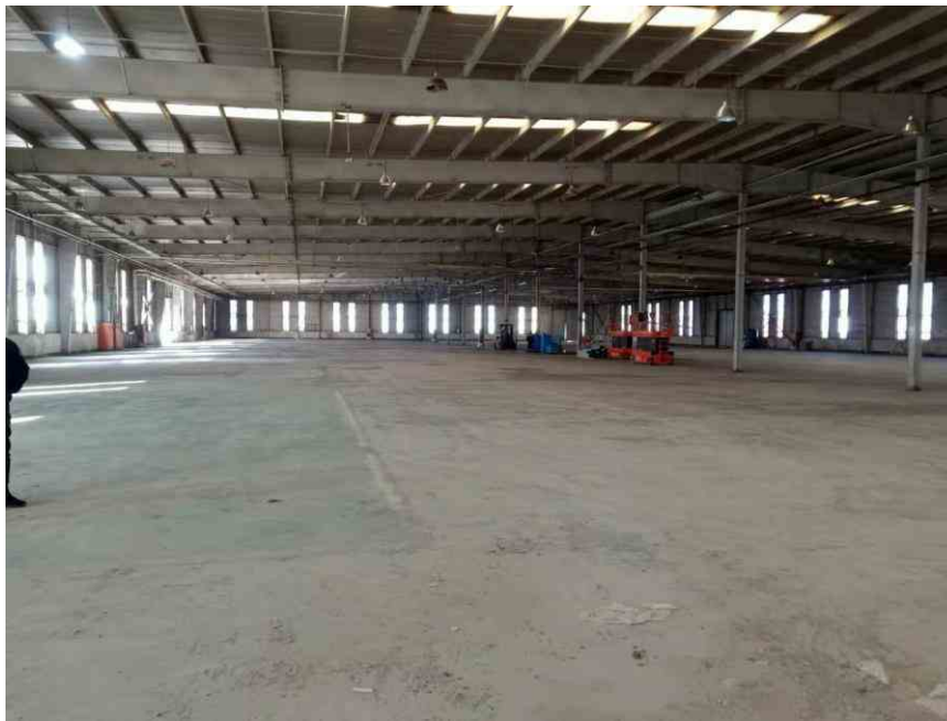
图 5.租赁厂房现状照片
