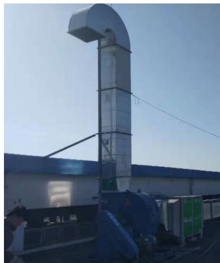
图 4-2 现有 P2 排气筒规范化图
