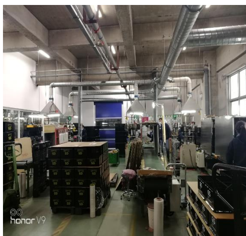
图 3-9 印刷车间集气罩及收集管道分布
