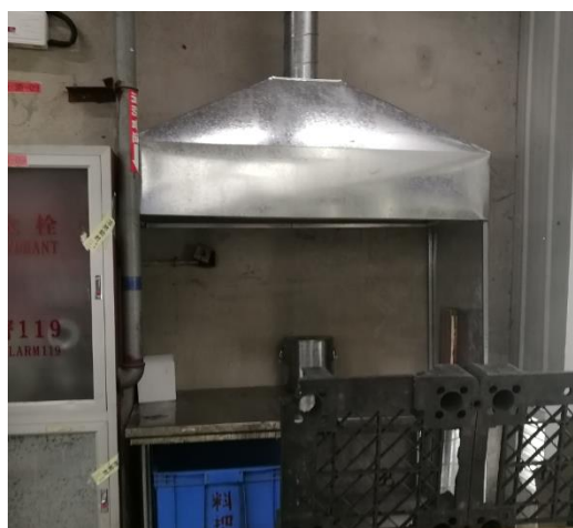
图 3-10 印刷车间擦拭废气集气罩
