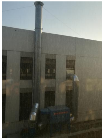
图 1.5-1 天津市欧达法斯克制冷设备有限公司除尘设备及排气筒
