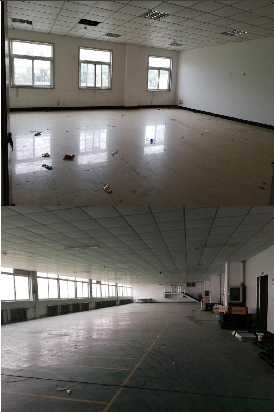
图 1-4 厂房现状照片
