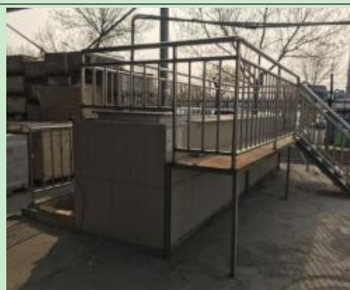
图 3 废水总排口排水明渠
