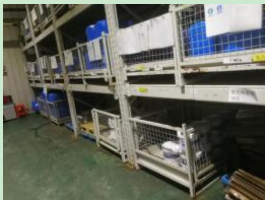
图 3 化料库地面防渗
