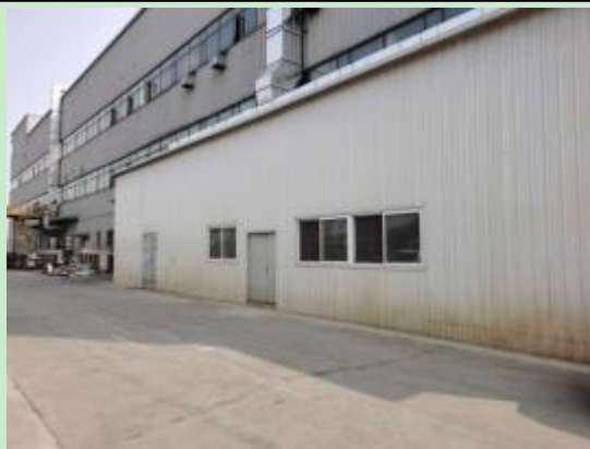
图 1 滤筒除尘器设备间
