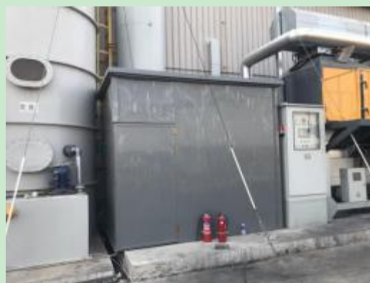
图 2 VOCs 净化装置风机隔声罩
