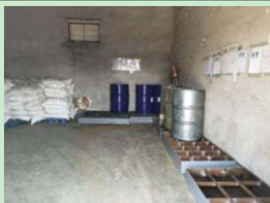
图 1 化料库地面硬化、防渗及防漏托盘
