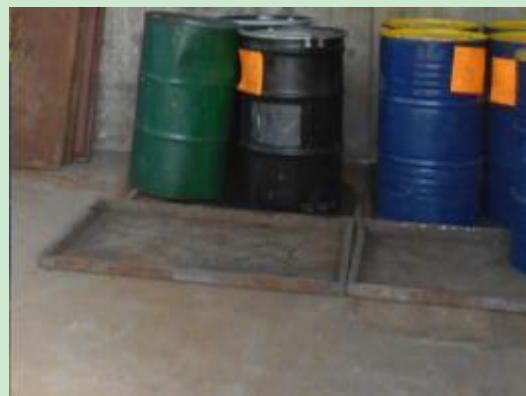
图 4 危废间地面防渗，防渗漏托盘
