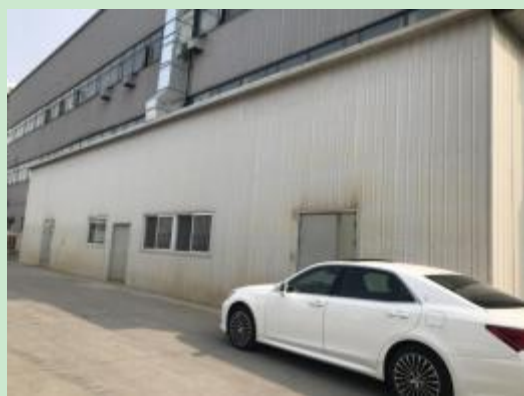
图 1 滤筒除尘器隔声措施
