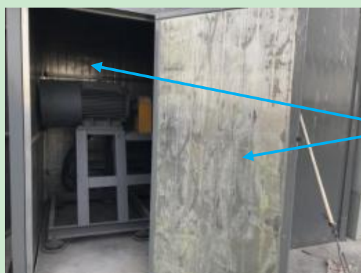
图 3 隔声罩内部 (四侧墙壁吸声材料、风机减振基础)
