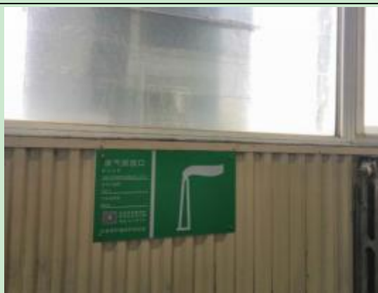
图 4 滤筒除尘器标识牌
