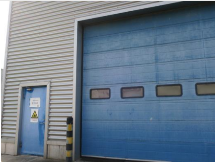
图 3 一般固废暂存场所
