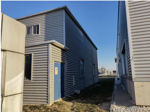
图 3 厂区西侧租赁的污水处理设施
