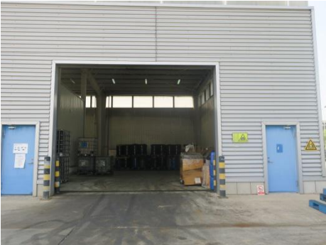
图 1 危险废物暂存场所
