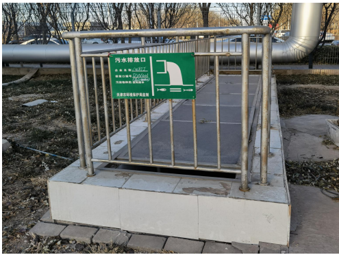
图 4 厂区西侧废水排放口及标识牌
