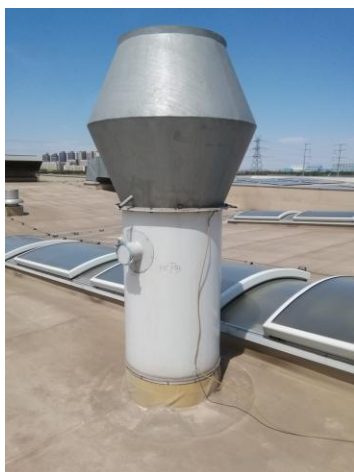
机加工粉尘排气筒 P93
