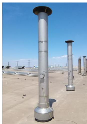
热处理燃气废气排气筒 P65
