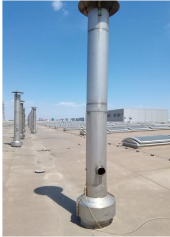
热处理燃气废气排气筒P71
