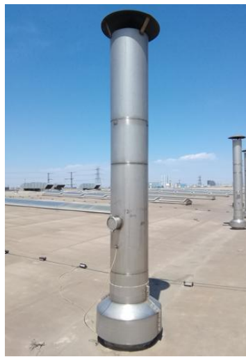
气体发生器废气排气筒P75
