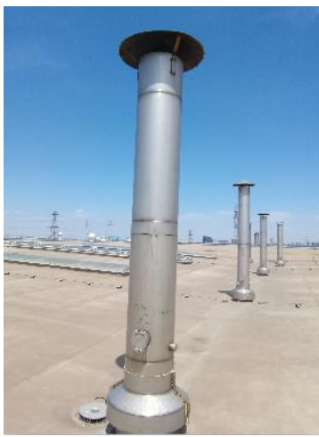
气体发生器废气排气筒 P74
