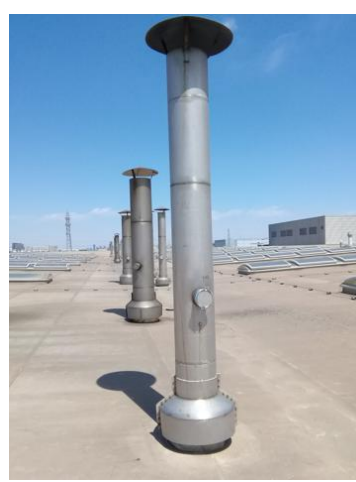
热处理燃气废气排气筒 P69
