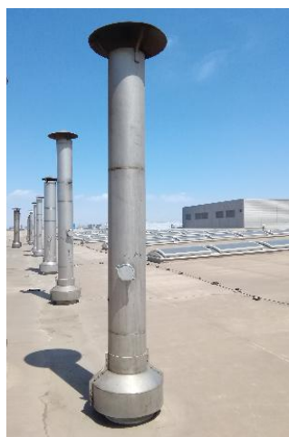
热处理燃气废气排气筒 P68
