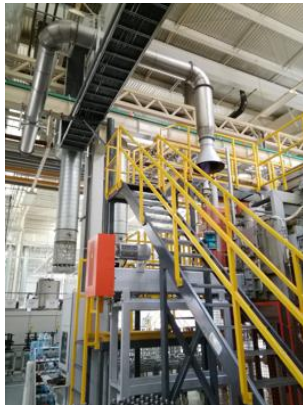
热处理炉燃气位置
