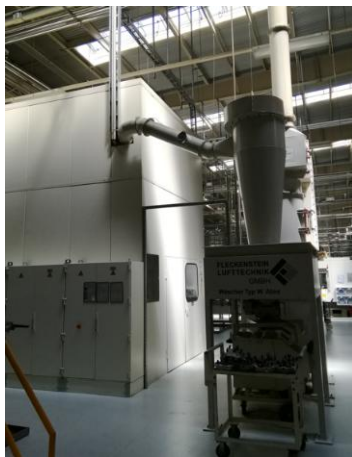
排气筒P64对应的除尘器
