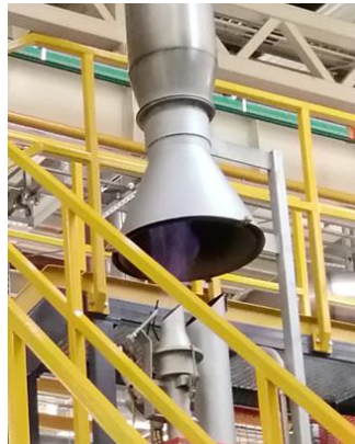
热处理炉燃气位置
