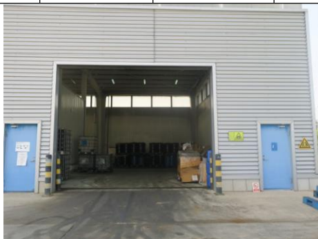
危废暂存库外部
