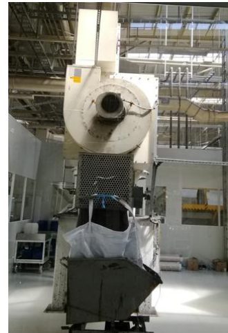
排气筒P63对应的除尘器
