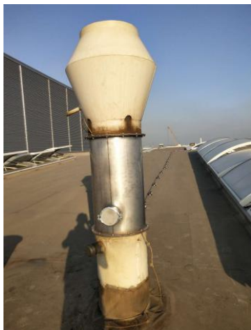
抛丸废气排气筒P64
