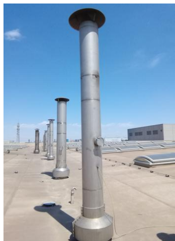
热处理燃气废气排气筒 P66
