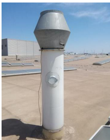
机加工粉尘排气筒P94
