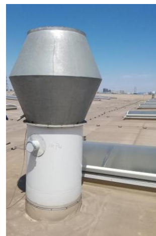
机加工粉尘排气筒P96
