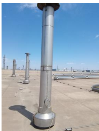
热处理燃气废气排气筒 P56
