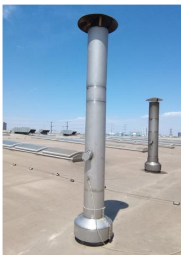
热处理燃气废气排气筒 P60
