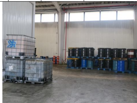
危废暂存库内部
