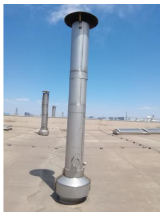
热处理燃气废气排气筒 P54
