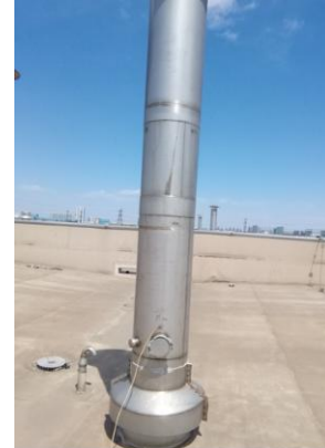
热处理炉燃气废气排气筒 P 53
