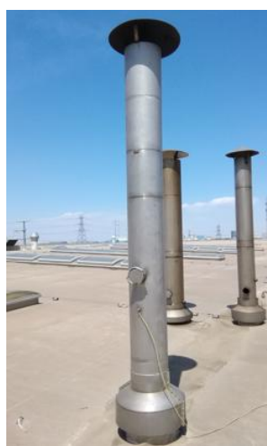
热处理燃气废气排气筒 P59
