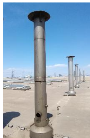
热处理燃气废气排气筒 P57
