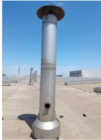
热处理燃气废气排气筒P72
