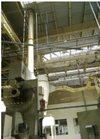
排气筒 P62 对应的除尘器
