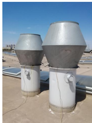
机加工粉尘排气筒P91（左 边）、P92
