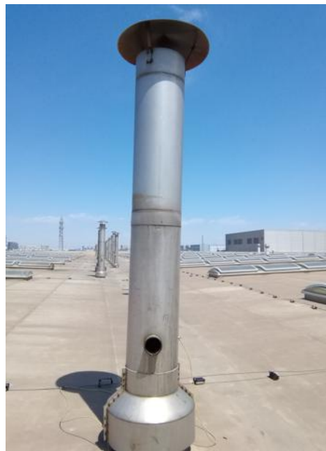
热处理燃烧废气排气筒P17
