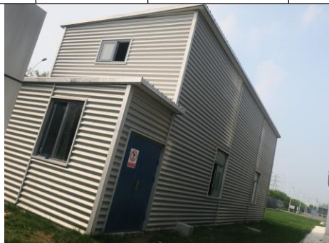
生活污水处理设施
