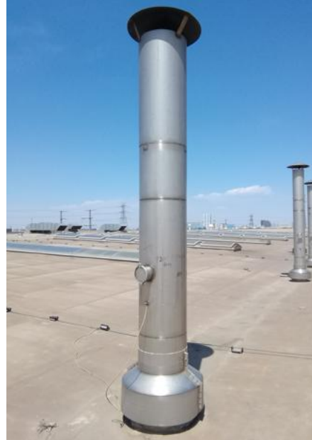
气体发生器废气排气筒P20
