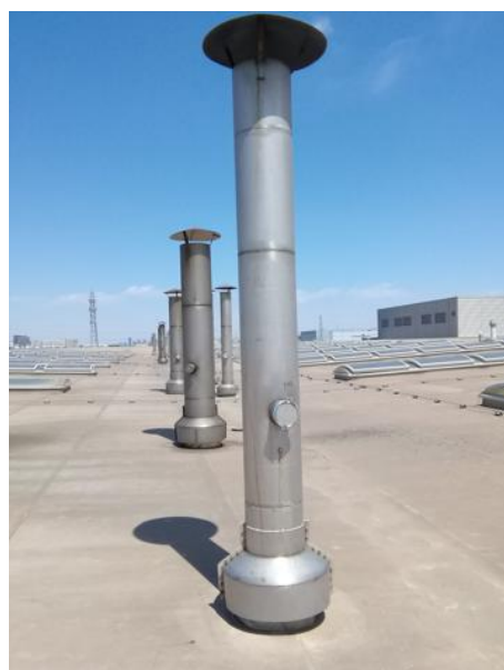
热处理燃烧废气排气筒P14
