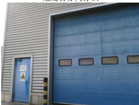
生活垃圾暂存间
