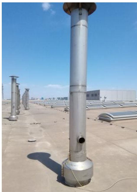
热处理燃烧废气排气筒P16
