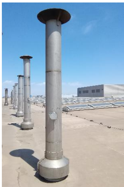
热处理燃烧废气排气筒P13
