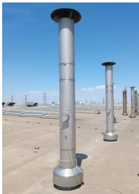
热处理燃烧废气排气筒P 10
