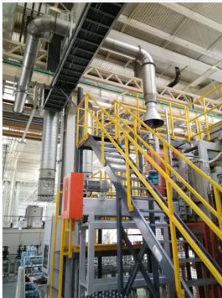
热处理炉燃气位置
