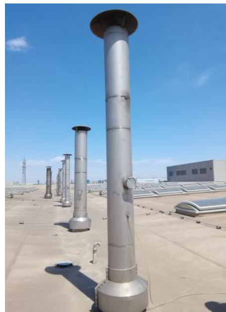
热处理燃烧废气排气筒P 11
