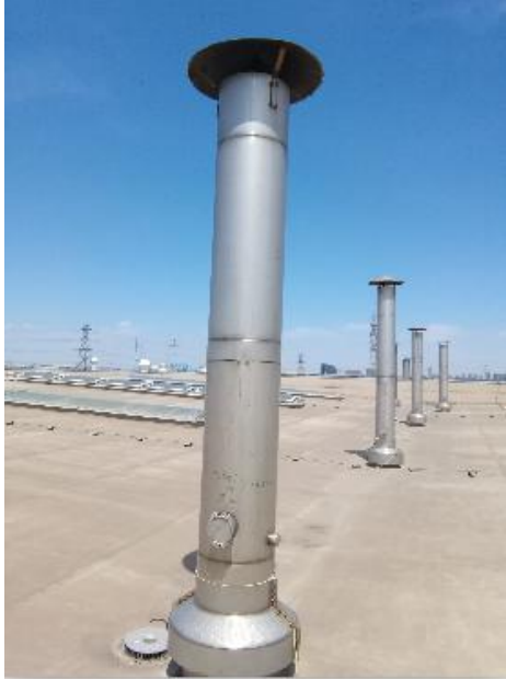
气体发生器废气排气筒P19
