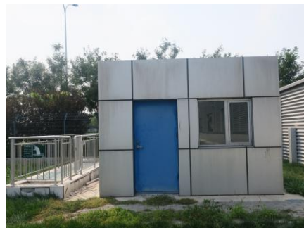
厂区西侧废水总排放口
