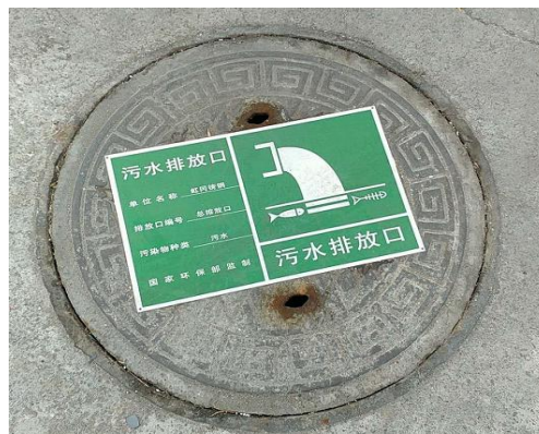
图 2 厂区废水总排放口
