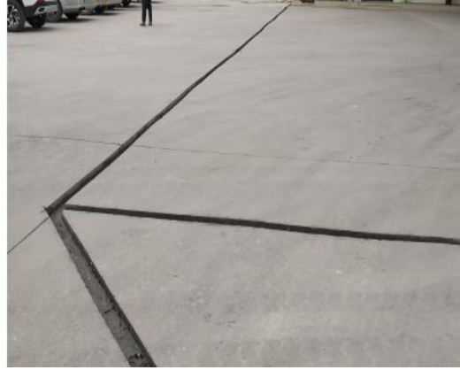
地面冲洗水收集沟
