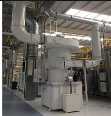
图 2 油雾净化装置照片
