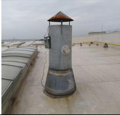
图 3 抛丸废气排气筒
