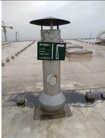
图 1 热处理炉排气筒及标识牌
