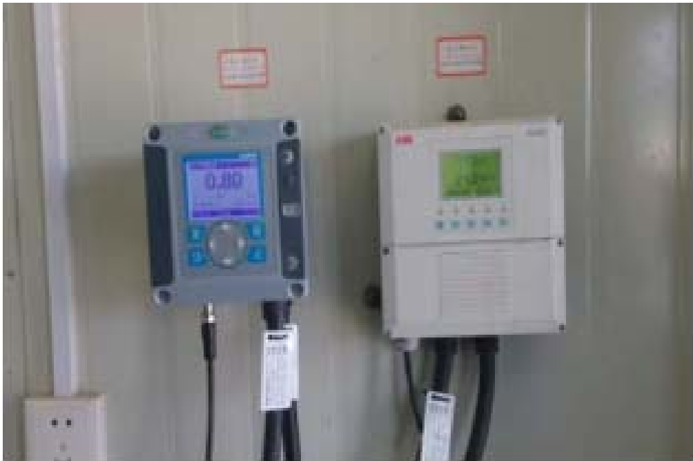
图 4.9 污水排放在线监测装置
