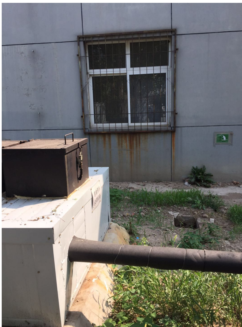
废水排放口照片
