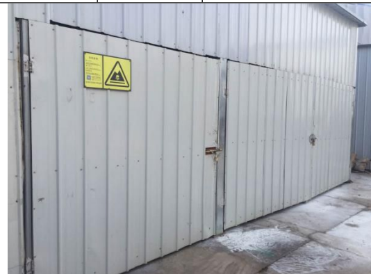
图 2.厂区内危险废物暂存间 (外部)
