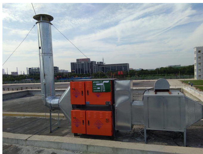
图 4 食堂油烟净化设备及排气筒 P1
