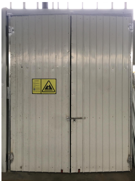
危废暂存库外部
