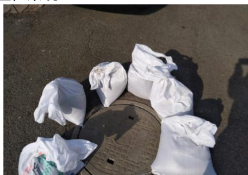
图 4.2-4 用于雨水排口封堵的沙袋
