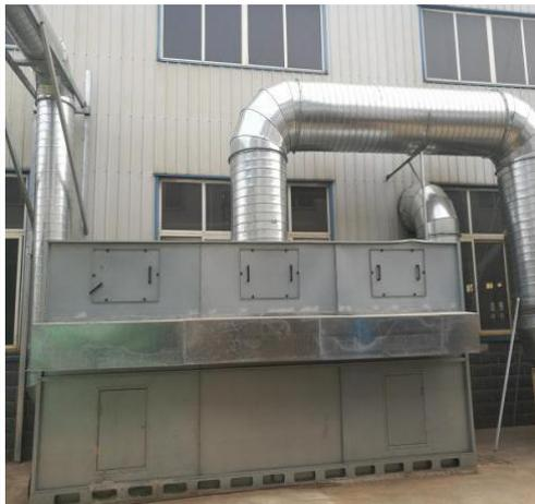
图 1.滤筒除尘器
