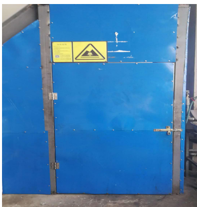
图 1 危废暂存场所（外部）
