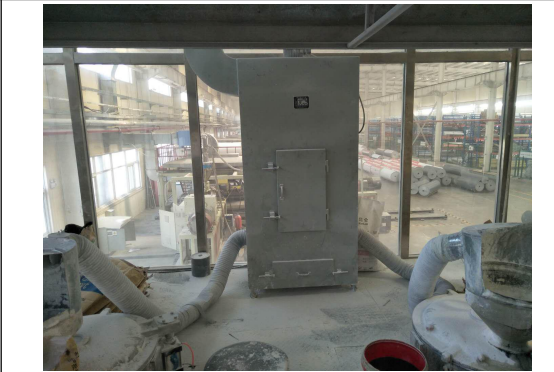
图4 排气筒P 6 对应的除尘器（进气管道为软连接）
