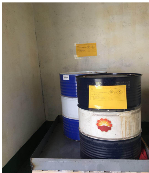
图 2: 危废暂存场所（内部）
