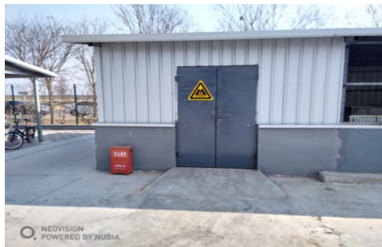
图 4.8 危险废物暂存处
