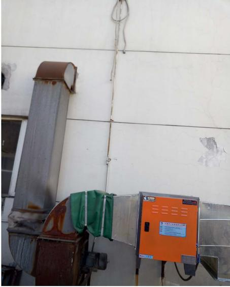
图 1 废气处理设施照片
