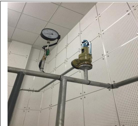
图 8.管路压力表及安全阀
